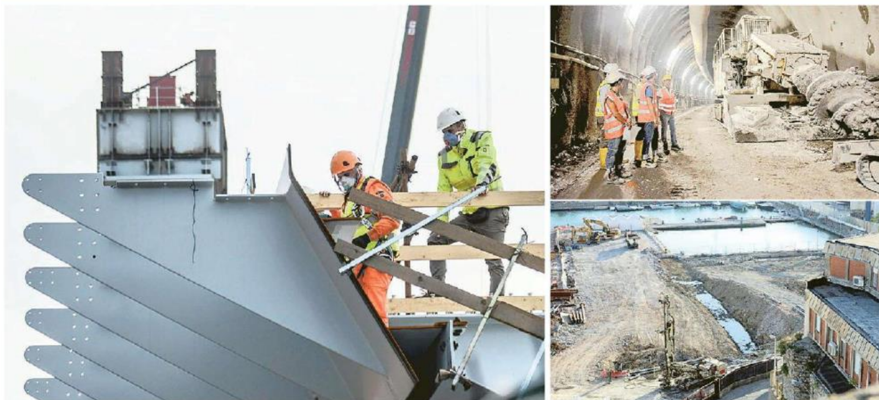
A sinistra operai al lavoro su un impalcato del nuovo ponte; a destra i lavori per il Nodo Ferroviario e quelli per il nuovo canale del waterfront, alla Foce
